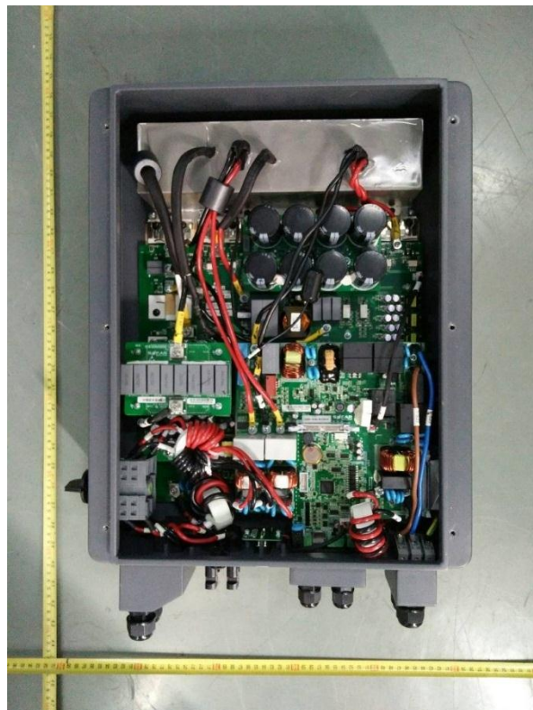
Figura 4, Visão interna Figure 4, Internal view
